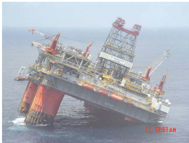
14.04.2000. Разрушение буровой установки «NDC Al Mariyah», в результате которого 5 человек погибло и 8 получили ранения.
