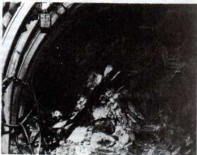
Поднятие пород почвы вдоль стенок выработки
