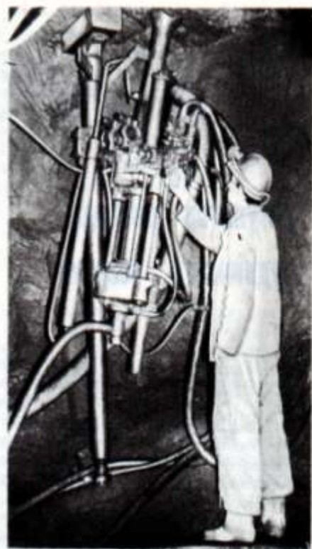
Рис. 2. Бурение скважины с применением шламоуловителя
