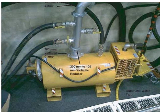
Рис. 8. Отделение воды после бурения и система мониторинга и безопасности, примененные компанией VLD на скважинах шахты Soldier Canyon Сепаратор
