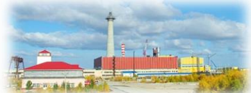
Уренгойская ГРЭС – 450 МВт
