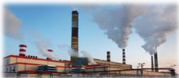
Киришская ГРЭС, бл. 6– 540 МВт
