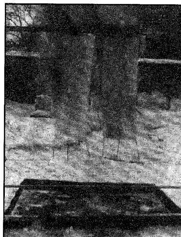
Испытания (1935 г.) ЦНИПЛ НКВД СССР по определению качества огнезащитной пропитки: а) ткань до испытания; б) ткань горит; в) ткань после сжигания (правое, не обработанное пропиткой полотно сгорело)
